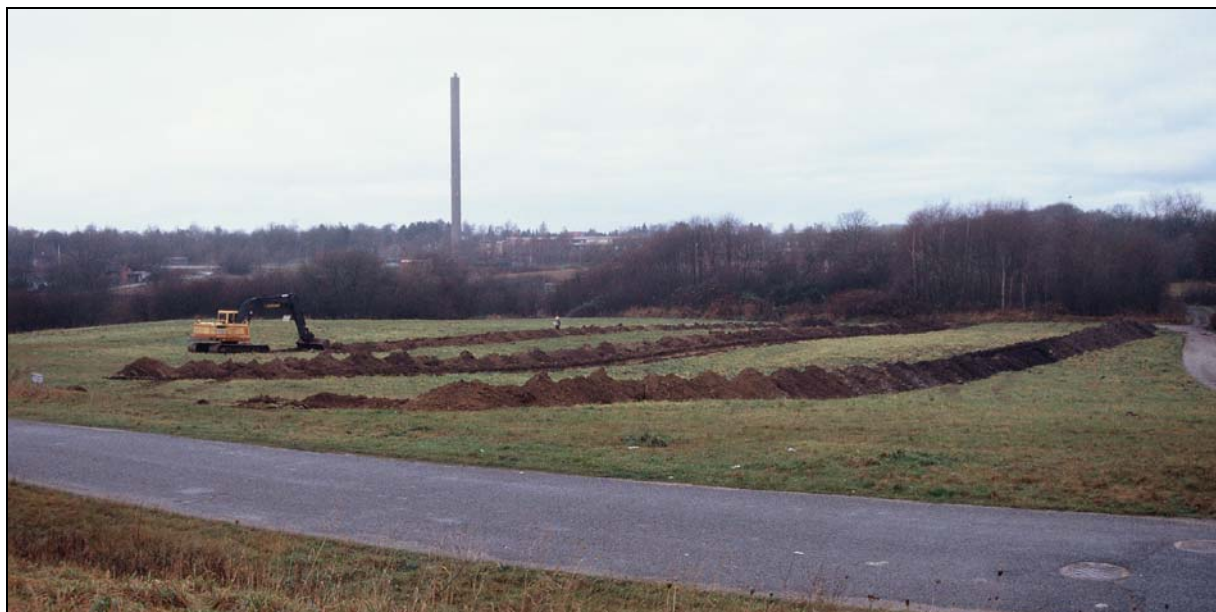
Figur 2: Prøvegrøfter trækkes på det lettere sumpede område, nr. 5, vest for Elmegårdsvej.
