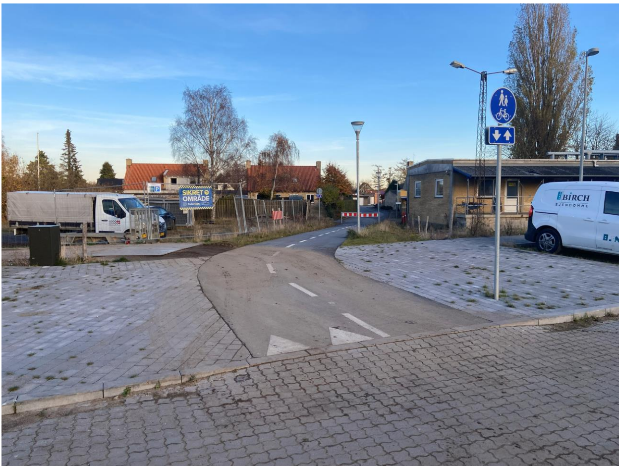
Foto af fælles cykelsti for området set fra vest. Cykelsti er ført ud til Lystrupvej mod øst.
