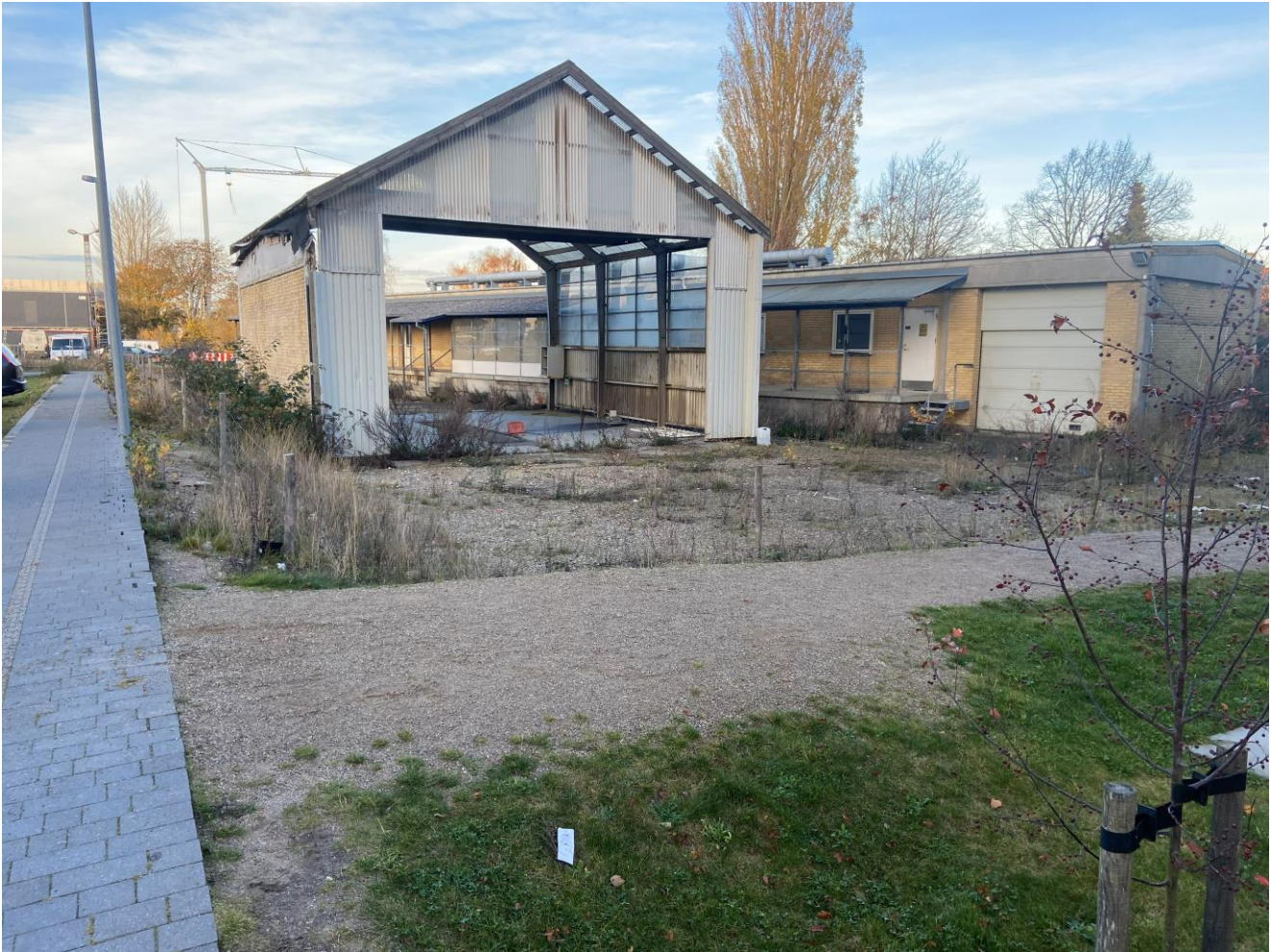
Foto af den sydlige del af Storparcel 1, hvor der er eksisterende bygninger til nedrivning.
