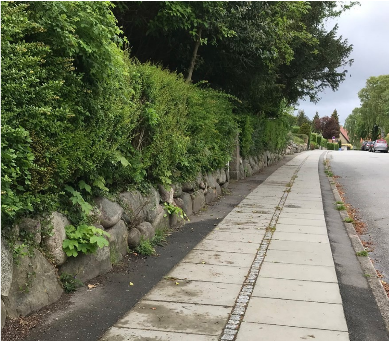
Billede fra Holtevej i Aarhus der viser forhaver med lav hækbeplantning og terrænregulering i skel i form af støttemur i kampesten.
