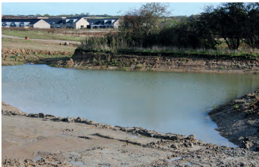
Regnvandsbassin under anlægsfasen
