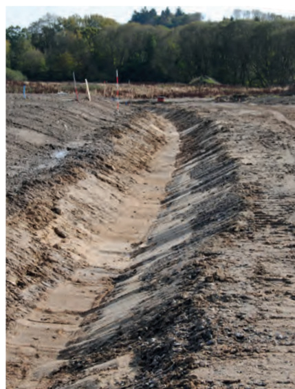
Grøfter/wadier under anlægsfasen
