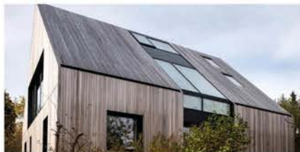
Renovering af 70'ervilla i Højbjerg har opdateret huset i forhold til bæredygtighed, energiforbrug, dagslys og forandret husets udtryk
