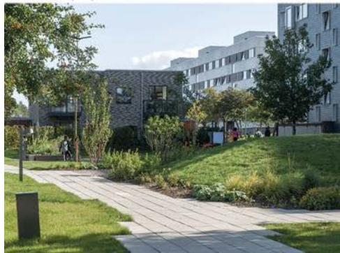
Rosenhøj - eksempel på renovering af alment boligområde
