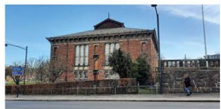
"Smykkeskrinet" på Vester Allé er opført som statsbibliotek, har været erhvervsarkiv, og er i dag en del af Retten i Aarhus
