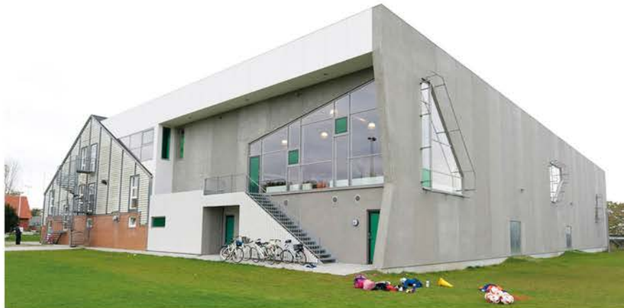
Springcenter Aarhus er en del af Vejlbj-Risskov Idrætscenter. Et centralt knudepunkt i lokalområdet, der tilbyder unikke ramme for bevægelse og foreningsaktiviteter
