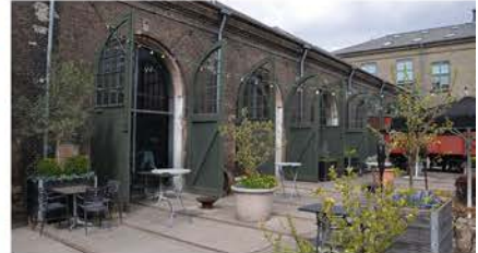
Centralværkstedet, Aarhus C. Nænsom omdannelse af tidligere industriarkitektur til serviceformål
