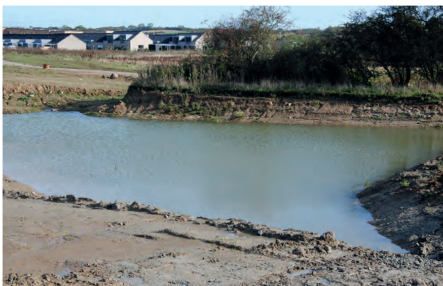
Regnvandsbassin under anlægsfasen
