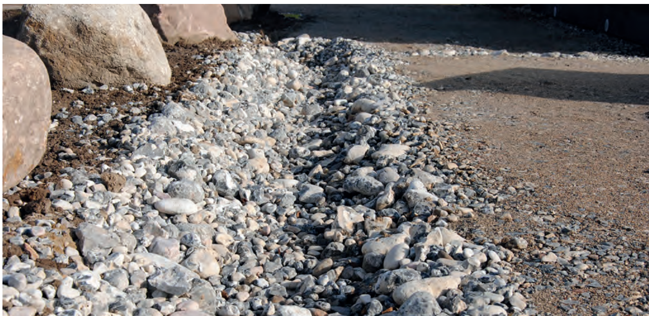
Grøfter/wadier under anlægsfasen
