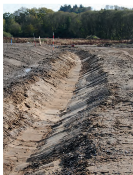
Grøfter/wadier under anlægsfasen
